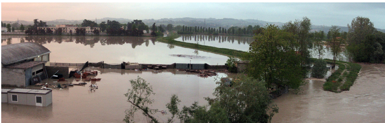
Foto 2: piena del 27-28.04.09, vista dal viadotto della tangenziale: si noti l'apertura in corrispondenza dell'inizio dell'arginatura di sinistra Tanaro immediatamente a valle della confluenza con il Loreto
